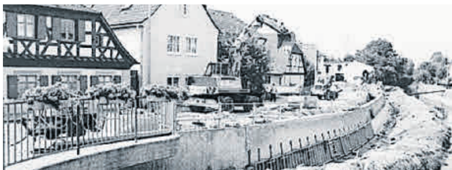
Sanierung der Leitenbachmauer, 21.7.1994, Foto: Ronald Rinklef, Bamberg
