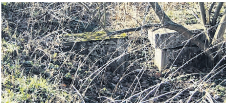
Ein Schütz an einem Wässergraben des Aubachs am 1.2.2007. Mit Brettern vor den Schützen wurde das Wasser aufgestaut.
