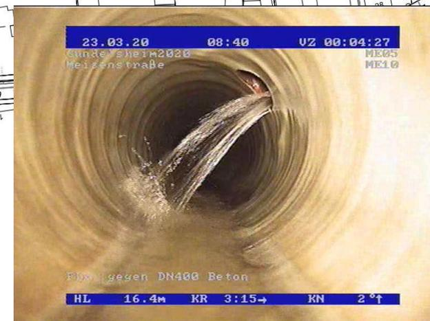
Kamerabefahrung des Kanals zeigt extremen Fremdwasserzulauf
