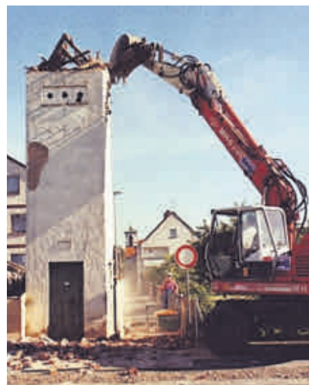
Abbruch des Transformators in der Kirchstraße im November 2000. Bildgeber: Norbert Wolf, Gundelsheim.
